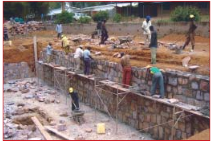
28 settembre 2007: lavori alla cisterna interrata
